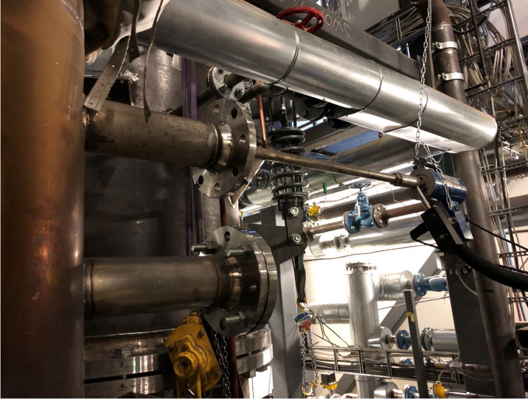
Kuva 3. Mittaussondi savukaasukanavassa
